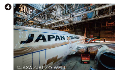
機体へのリブレット施工作業風景
