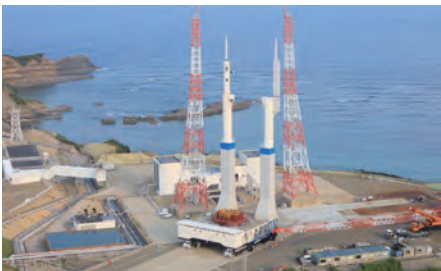
●白と水色でカラーリングされたマスト（柱）をもつML。上面デッキの高さは7m、頂部の高さは66.5mと巨大だ。
