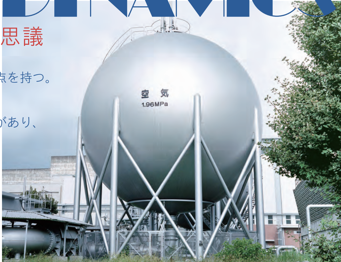
JAXA調布航空宇宙センターには、大きな空気タンクがある。これは航空機や宇宙機が空気中で飛行する際の風の流れを再現し、観察・検証・計測を行う風洞実験のために欠かせないもの。
