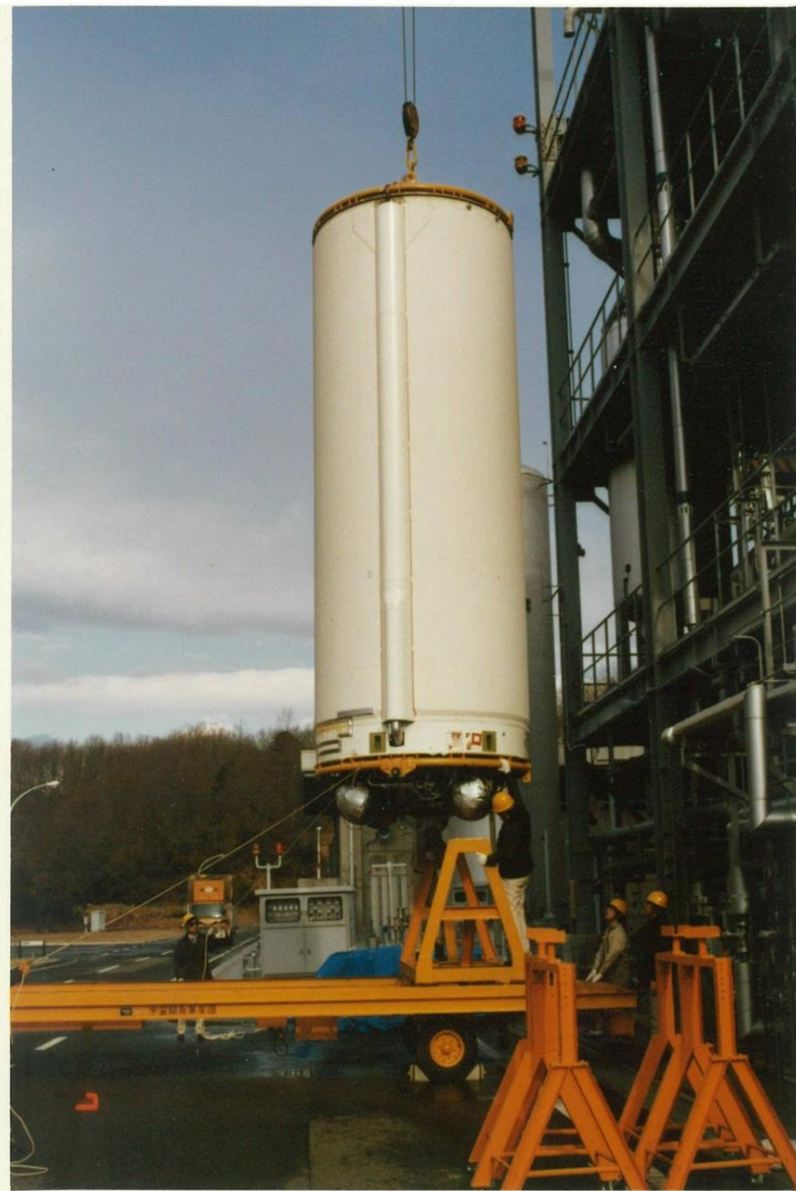
熱特性試験のためのTETS熱真空槽への第2段実機 型タンク搬入作業 【角田宇宙センター 旧TETS】[昭和60(1985)年2月 21日(木)]
