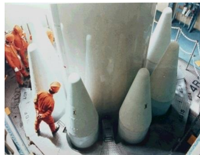
図2 H-I SOB取付け完了
