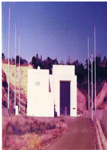
固体ロケット試験棟
