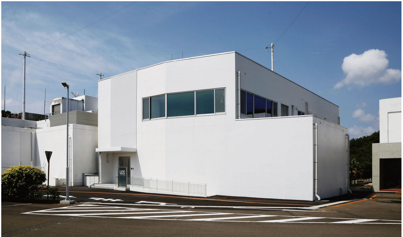
竹崎発射管制棟（LCC : Launch Control Center）
