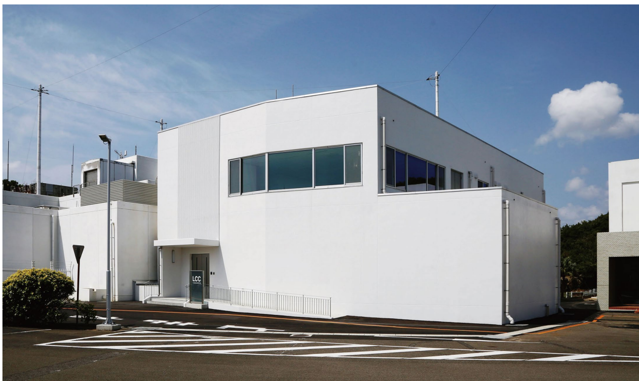
竹崎発射管制棟（LCC：Launch Control Center）
