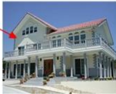
住宅への断熱材使用例
