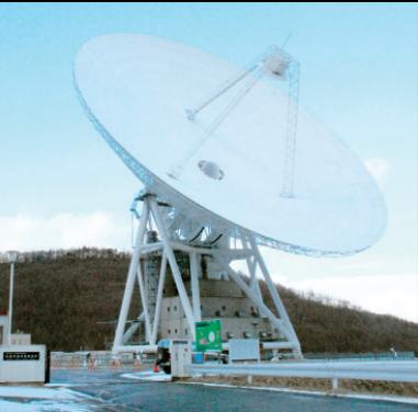
臼田宇宙空間観測所の直径64メートルの大型パラボラアンテナ。探査機の高精度軌道決定や、動作指令の送信、探査機からの観測データを受信する。行方不明になった「はやぶさ」からの信号を受信し、発見したのもこのアンテナだ
